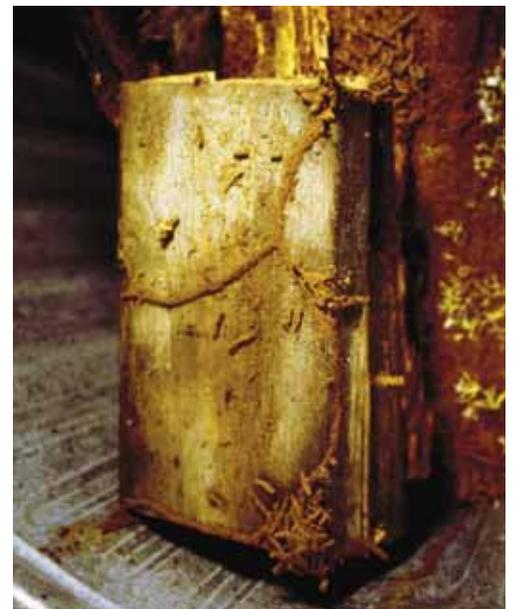
Fig. 16. Madera húmeda y caliente provee todo lo necesario para la sobrevivencia de las termitas subterráneas. (B. T. Forschler)
