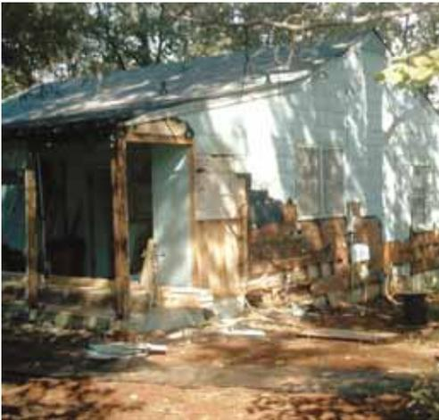
**Fig. 17.** *Tablas de un porche y pared exterior de una casa removidas para señalar el extenso daño causado por termitas.*
